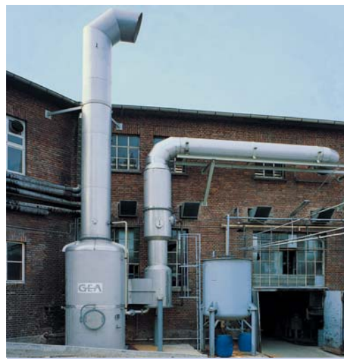
单效连续可调文丘里 洗涤装置U型 用于冲洗粉尘 吸入量: 30,000\text{ m}^3/\text{h} 压力损失: 20\text{ mbar}
