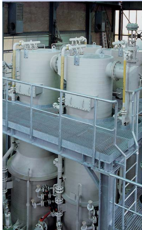
喷射洗涤装置类型 II 用于酸性和碱性废气
