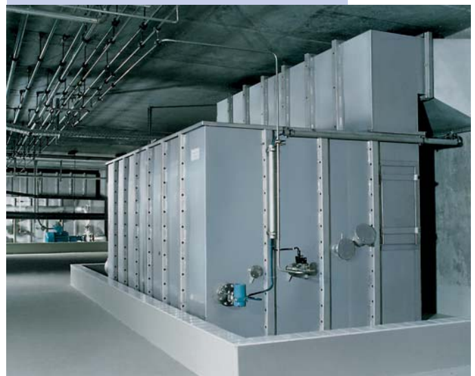
喷射洗涤器，用于 商务机油漆工厂的油雾分离 材料：不锈钢 1.4571
