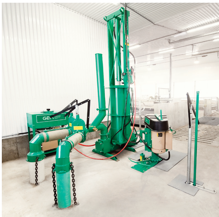
Sistema Electromix en el suelo por encima de la fosa de recepción. Instalación con doble descarga para la transferencia de estiércol en dos fosos diferentes.
