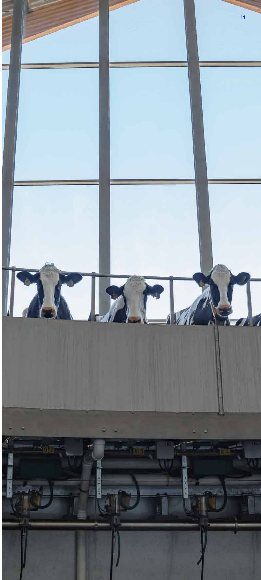
Melken rund um die Uhr – auf uneingeschränkte Verfügbarkeit ausgelegt.
