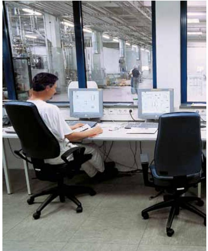
Über ein Bus-System ist ein zentrales Bedienen und Beobachten der Prozesse am Bildschirm möglich. Sollwerte und andere wichtige Parameter können in einem speziellen Parameterbild eingegeben werden. Die Anlage ist selbstüberwachend und geht bei Störungen automatisch in einen sicheren Zustand. Der Einsatz eines Mehrplatzsystems erhöht die Verfügbarkeit.
