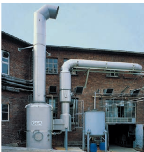
1-stufige stufenlos regelbare Venturiwaschanlage Typ U zum Auswaschen von Stäuben, Saugstrom: 30.000 \text{ m}^3/\text{h} , Druckverlust: 20 mbar.
