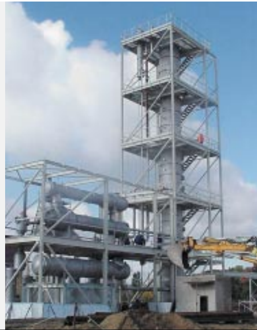
1-stufige Destillationsanlage zur Ethanolgewinnung, während der Montage
