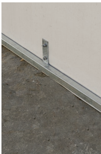
Het verstevigingsframe geeft het hok extra stabiliteit
