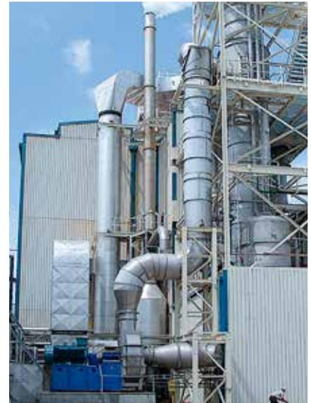
小麦淀粉污水使用的配备机械蒸汽再压缩机的单效降膜蒸发装置，蒸发率：17,000 kg/h
