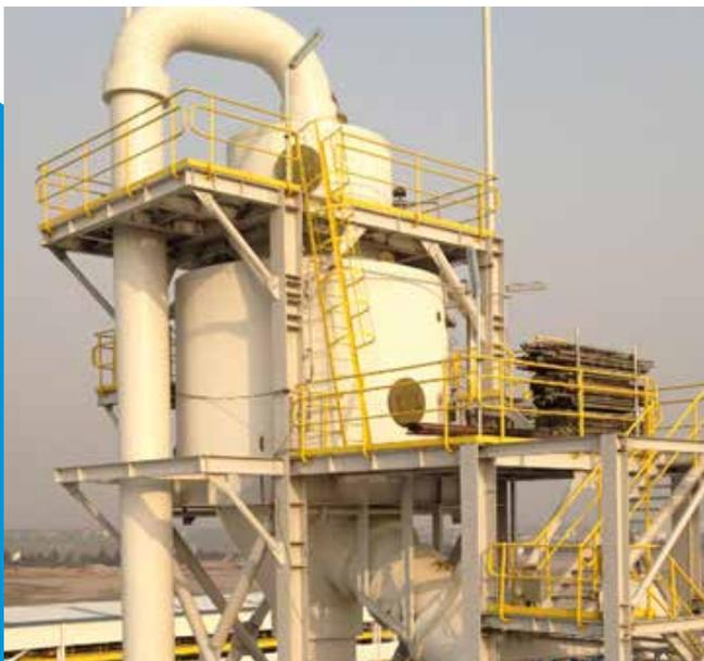
澳大利亚一家大型锂生产商在中国打造了一个以锂辉石矿石作为原材料的碳酸锂工厂。GEA为其提供了蒸发-结晶器，用于从含锂母液中析出硫酸钠。
