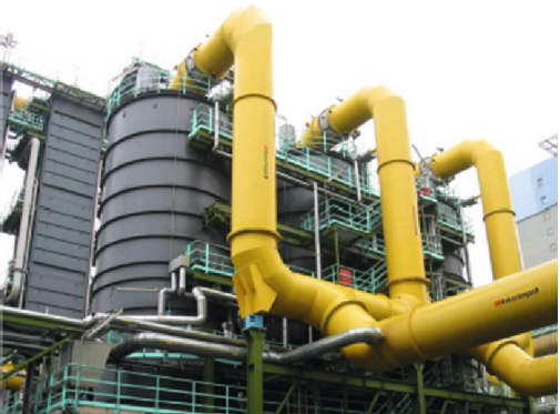
焦化厂烟气的脱焦油设备
