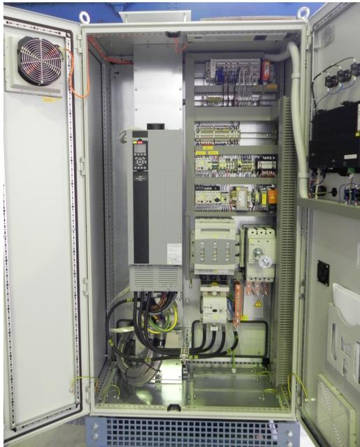
Abb.11: GEA Omni Schaltschrank Innenansicht (Frequenzumformer im Schaltschrank eingebaut)
