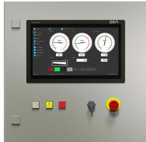
Abb.4: GEA Omni™-Schaltschrank mit Anzeigelampen
